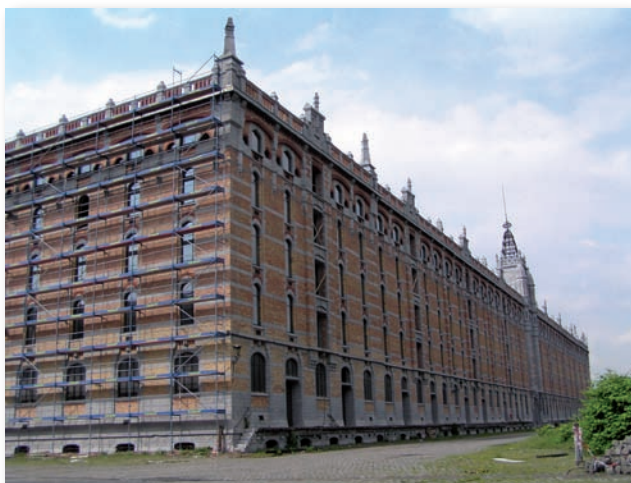
Les entrepôts de Tour et Taxis, Bruxelles. (Photo : Gracia Dorel-Ferré)
