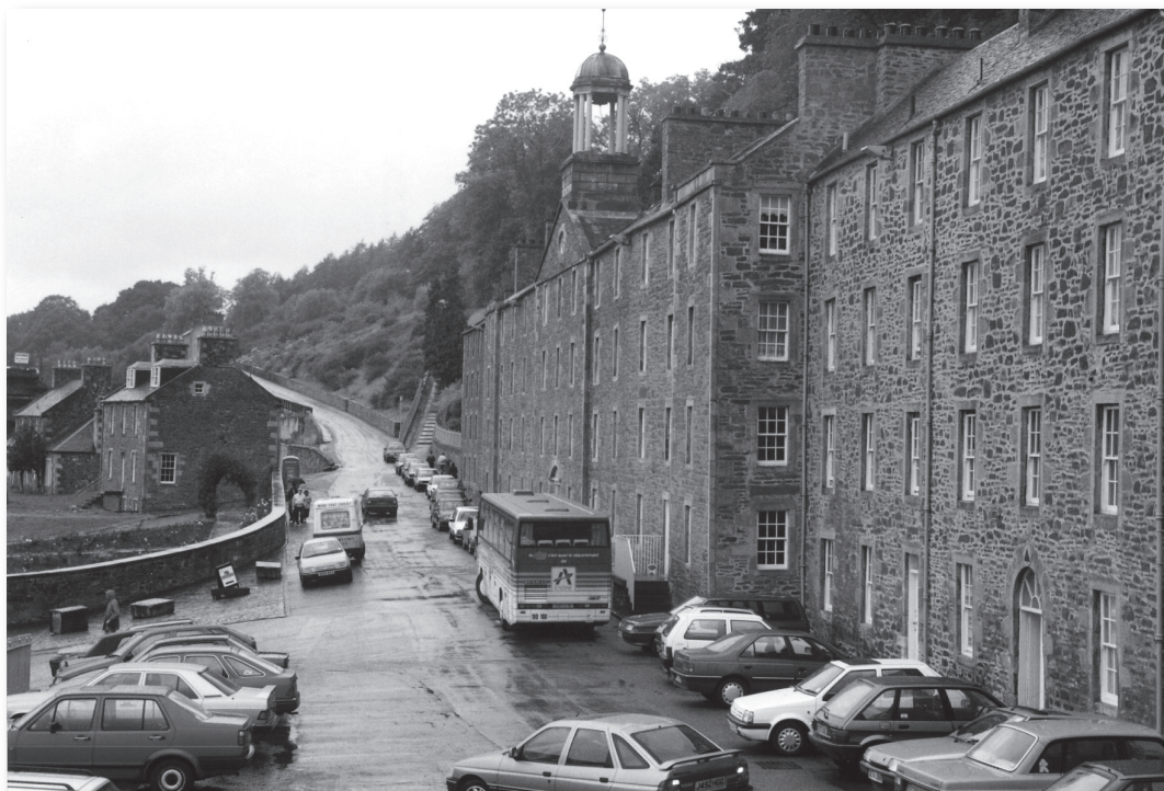
Les immeubles d'habitation à New Lanark (Ecosse) (Photo : Gracia Dorel-Ferré)
